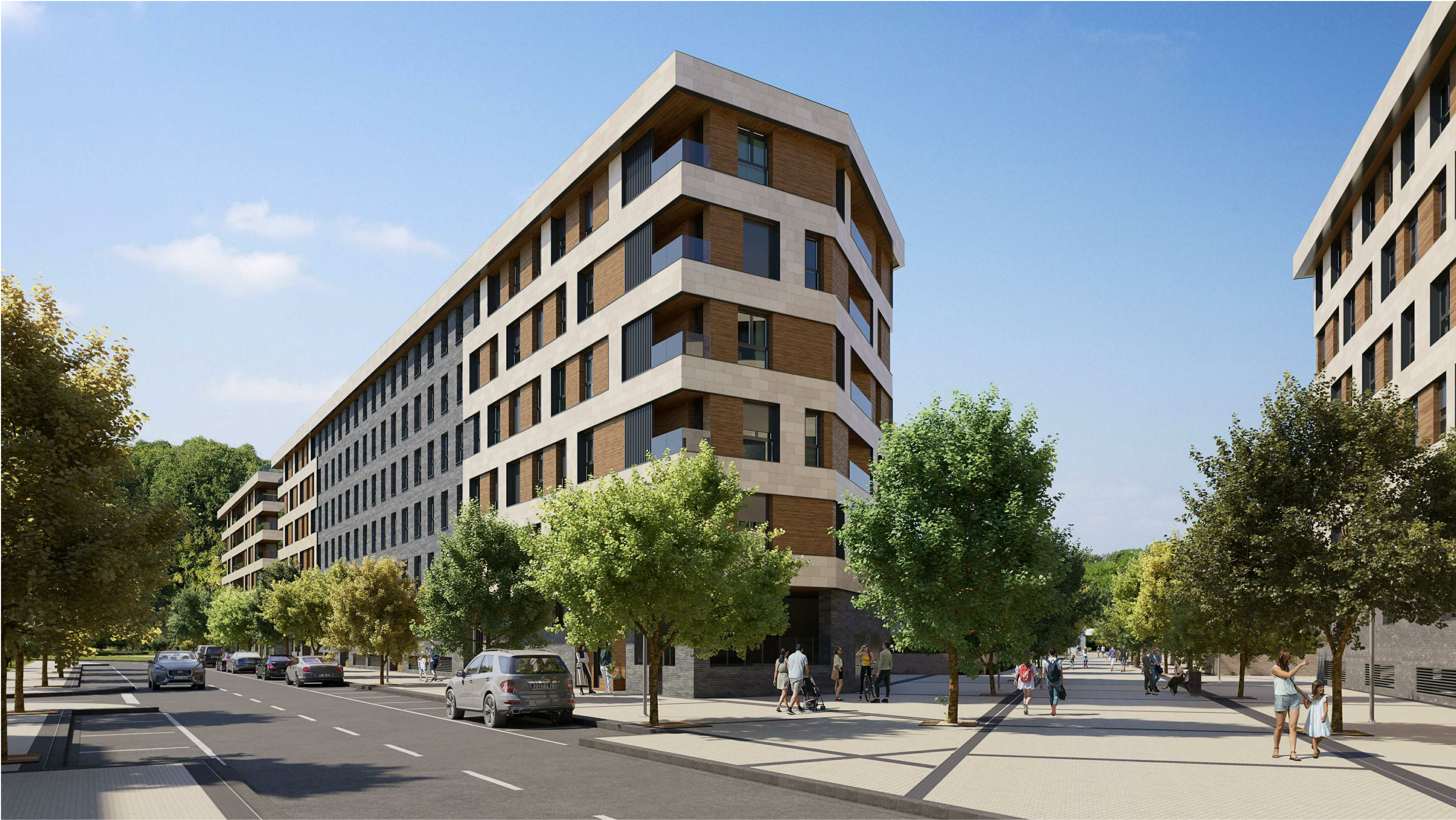
IMAGEN FACHADA NOROESTE . ZONA VIAL
