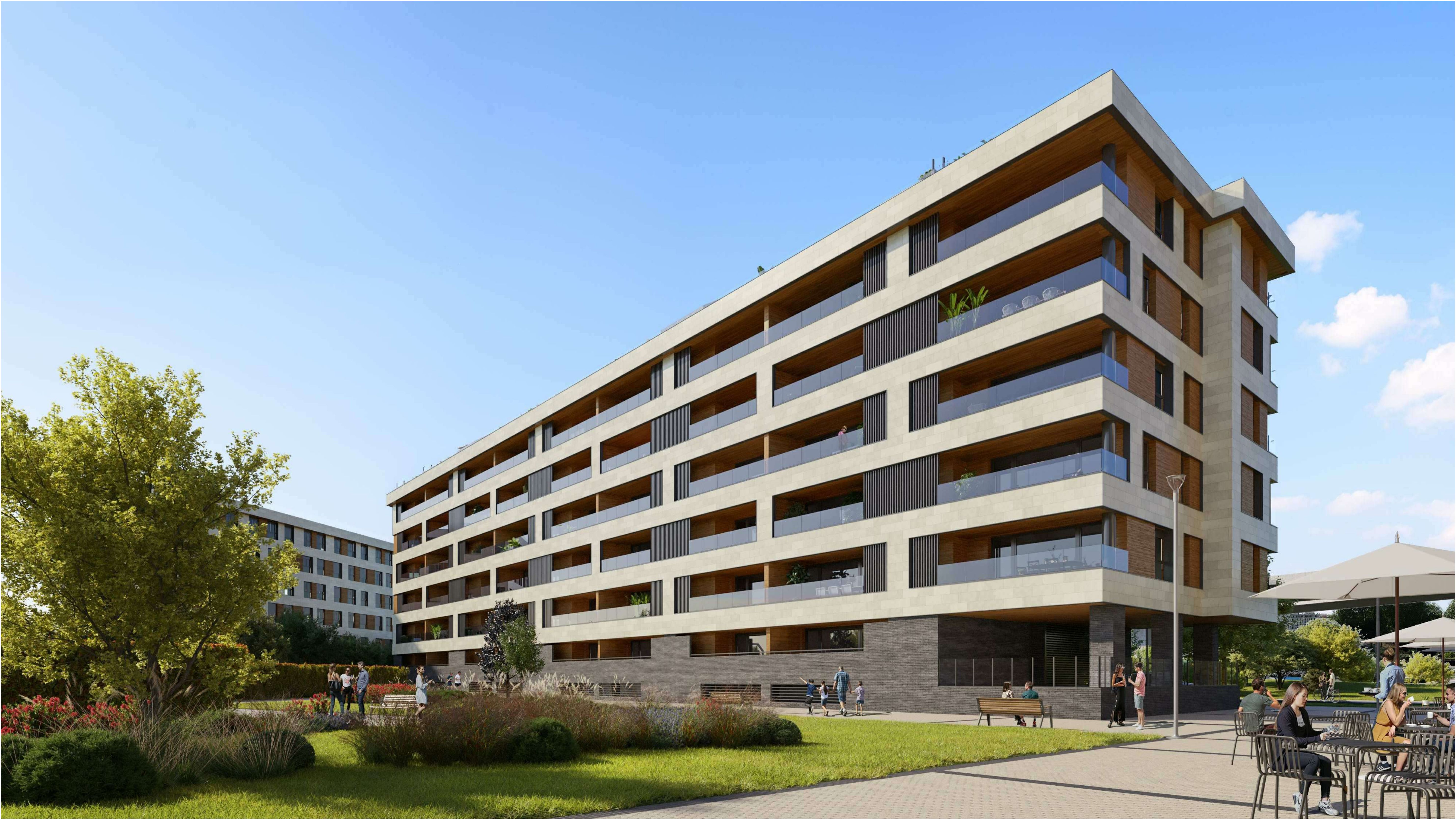
IMAGEN FACHADA SURESTE . ZONA PLAZA
