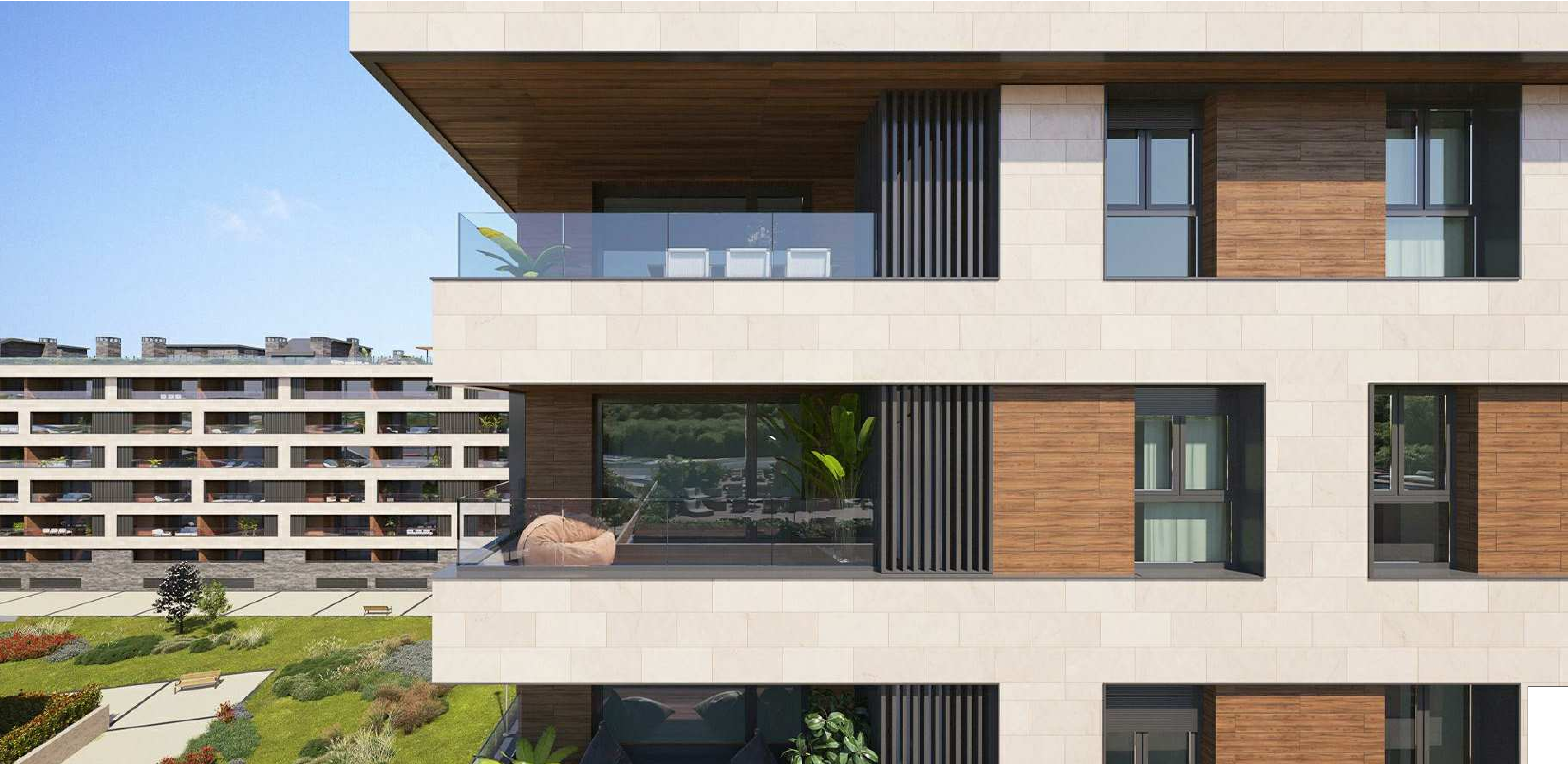
DETALLE DE FACHADA
